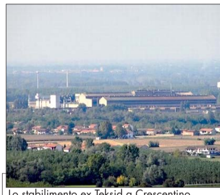
Lo stabilimento ex Teksid a Crescentino
